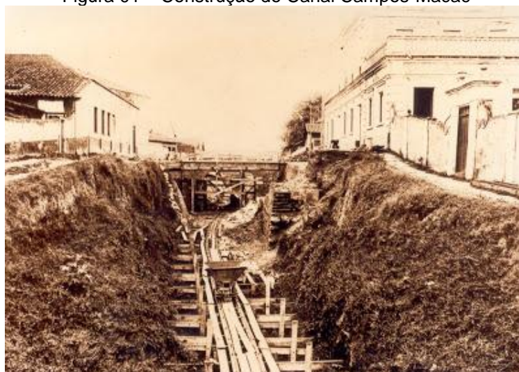
Figura 01 – Construção do Canal Campos-Macaé
