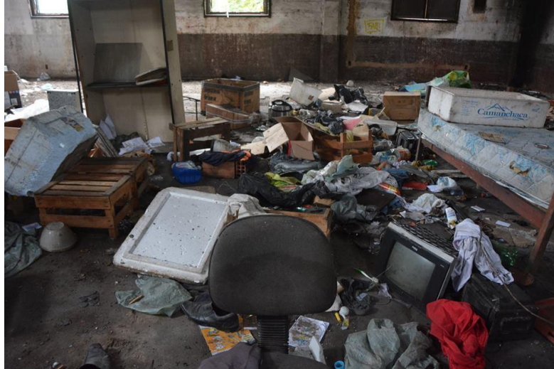
Figura 04 – Lixos e entulhos dentro do prédio.
